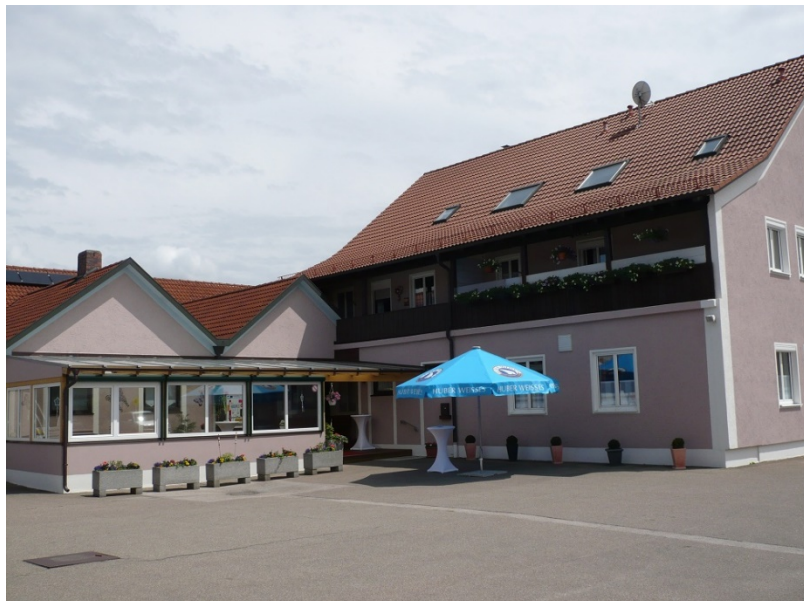
Gasthaus Riedmeier "Alter Wirt", Geisenfelder Straße 11, 85119 Ernsgaden
